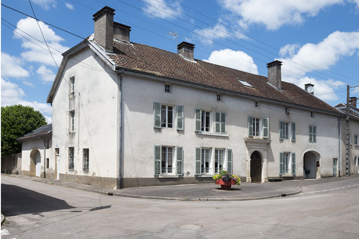
La façade antérieure : vue d'ensemble.
