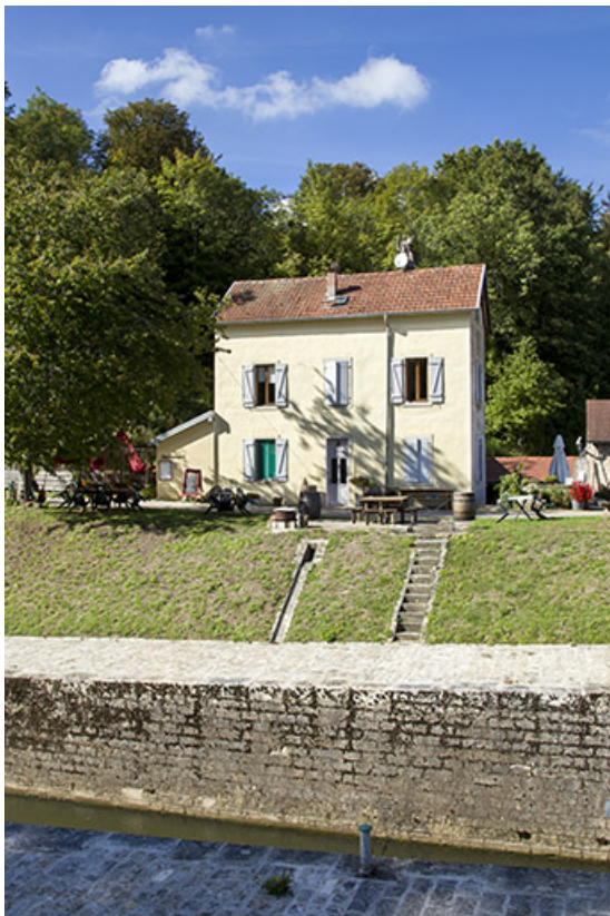
La maison du barragiste.
