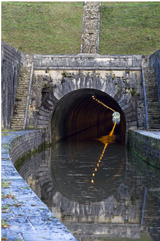
Le tunnel depuis l'aval.
