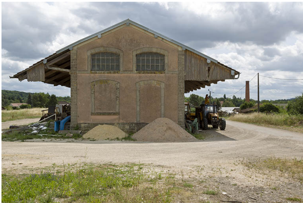
Le hangar de l'ancienne gare.
