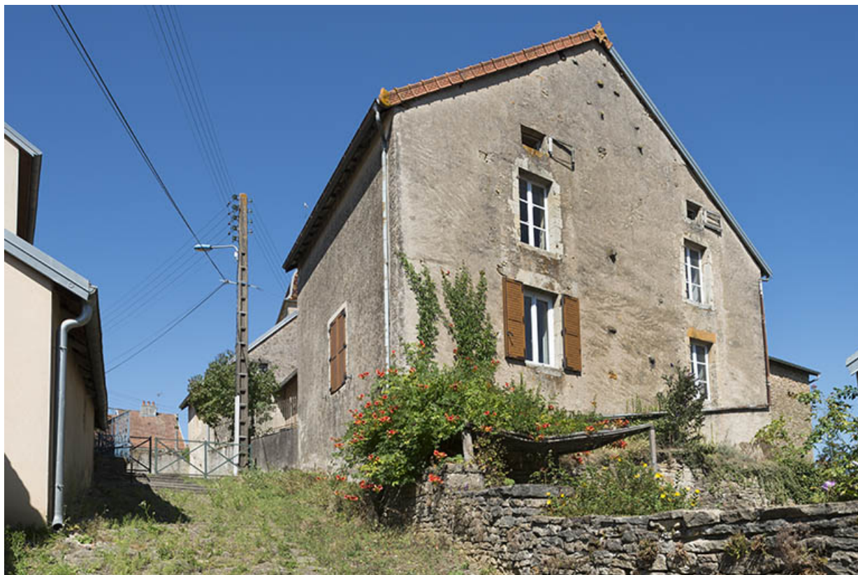
Le mur pignon côté sud.
