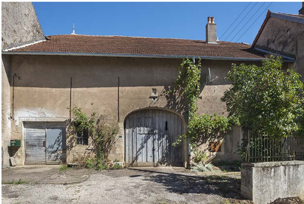
La porte cochère de la grange.
