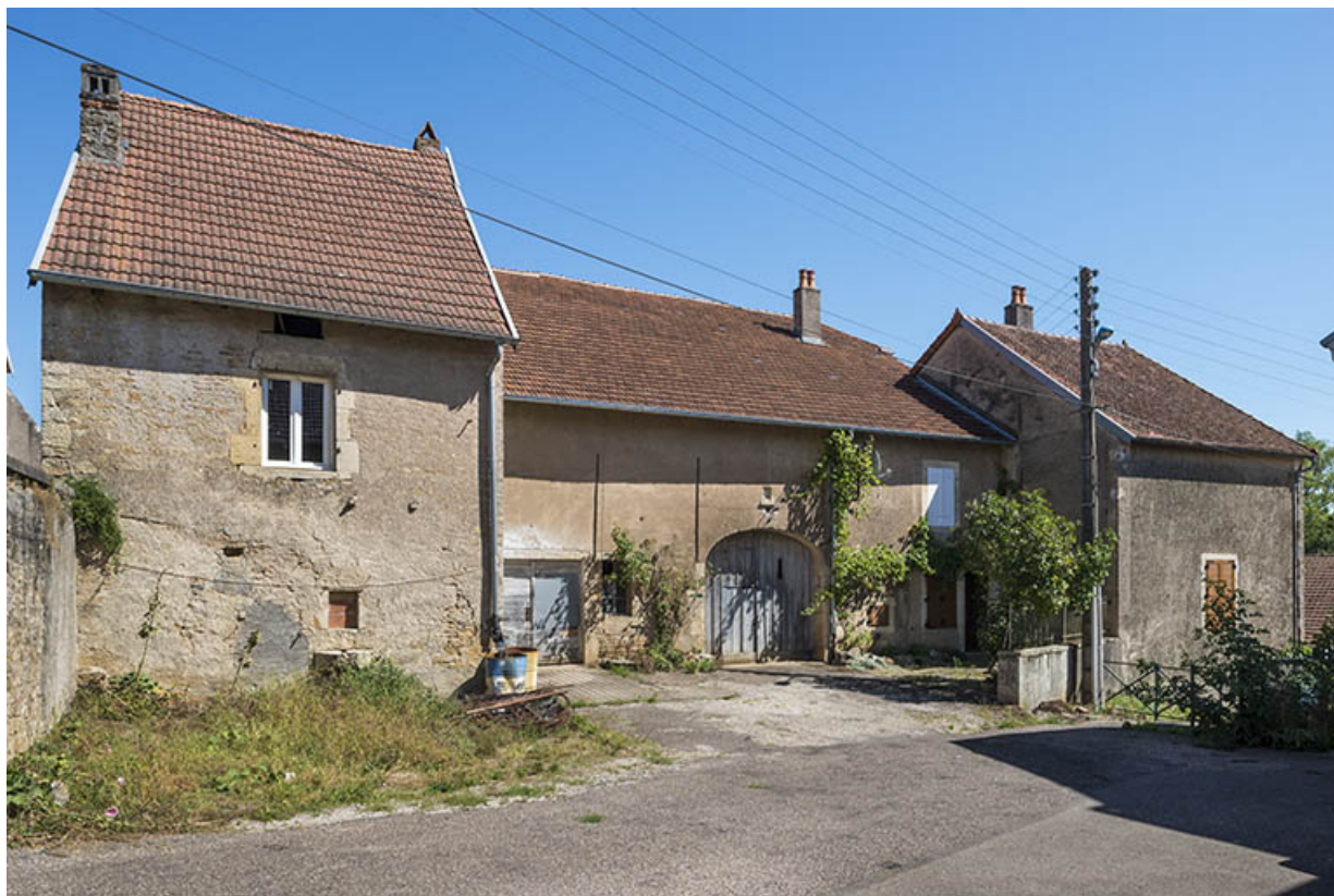
La façade antérieure.
