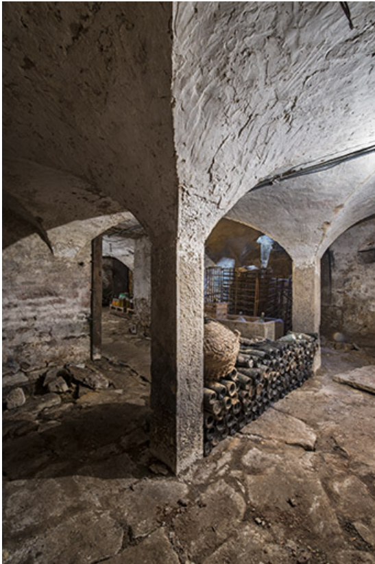
Détail d'une colonne supportant les voûtes.
