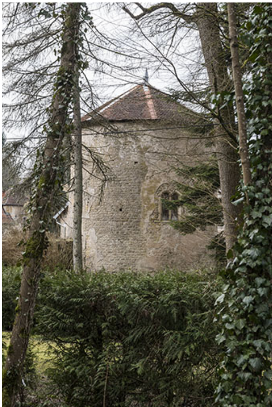
Tour située dans la cour du château.
