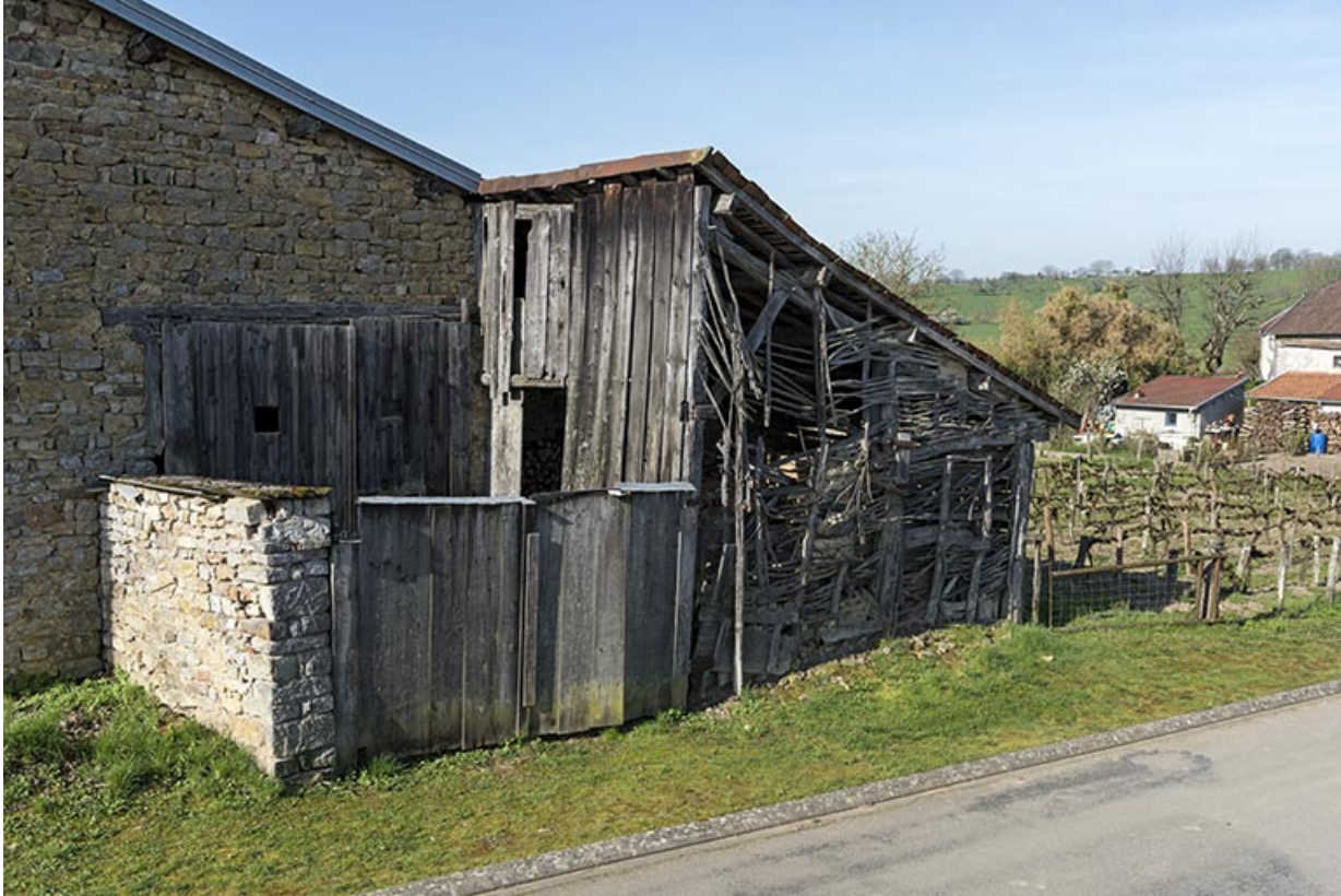
Détail d'un appentis couvert en tuiles canal, paroi en treillage, à l'angle de la Grande rue et de la rue de Jonvelle. 70, Betaucourt
