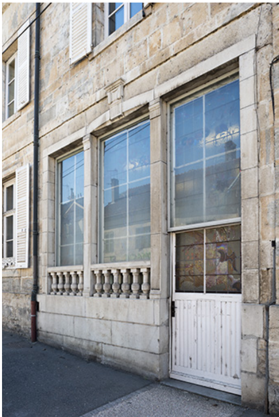
Partie occidentale de la façade antérieure.
