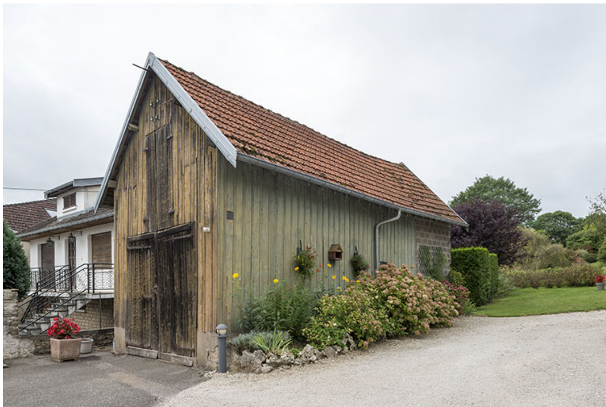
Le bâtiment à usage de garage.
