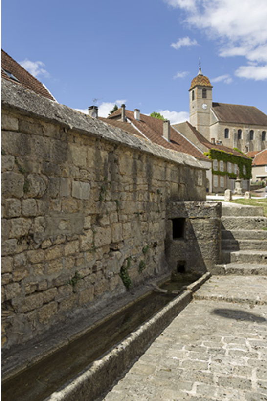
Fontaine-lavoir, 1 rue du Pâquis : l'arrivée d'eau. 70, Rupt-sur-Saône
