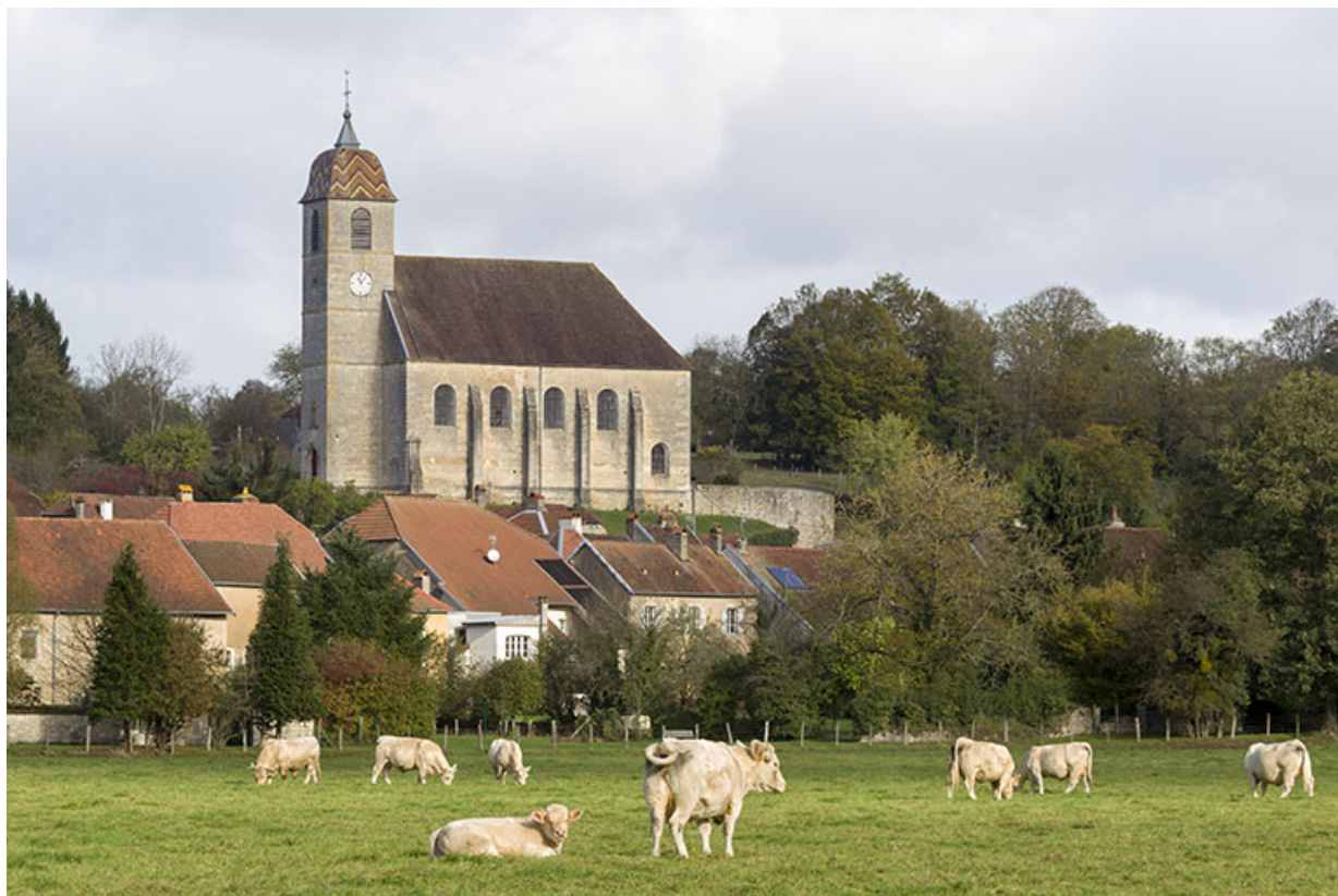
Vue générale en direction du Breuil.
