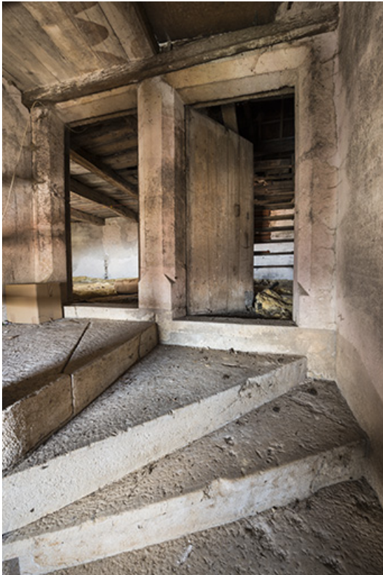
Portes d'accès aux combles depuis la tour.
