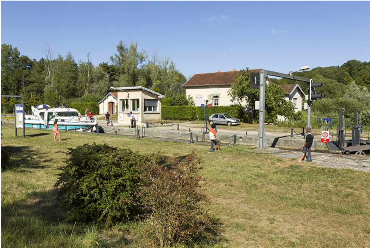
Vue d'ensemble du site d'écluse.
