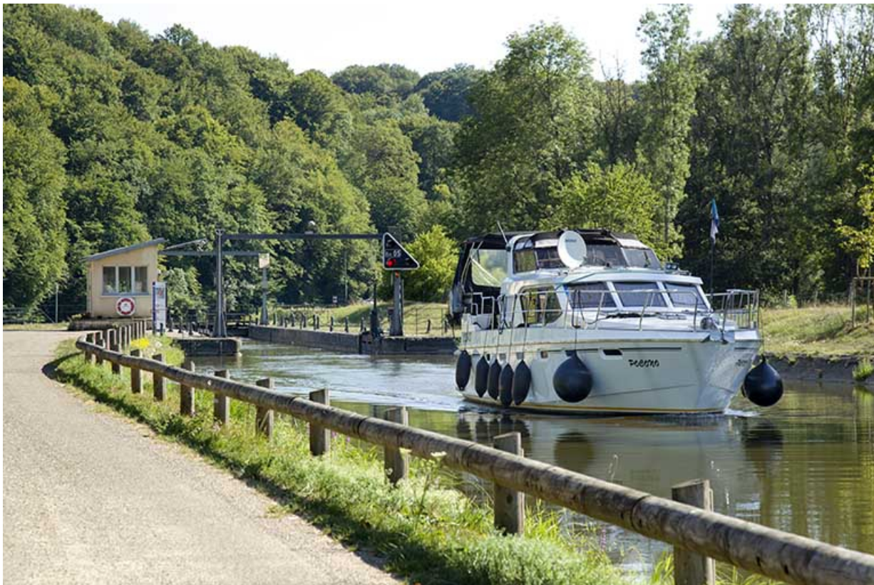
L'écluse de Port-sur-Saône.
