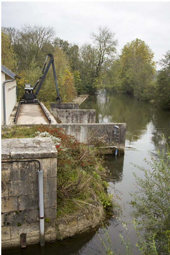
Appareil lié à l'entretien du canal.
