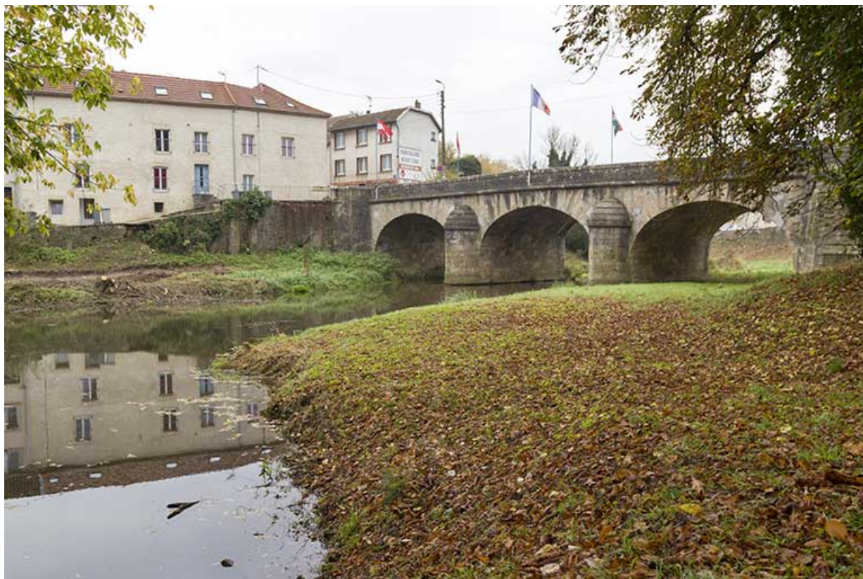
Le pont depuis l'amont.
