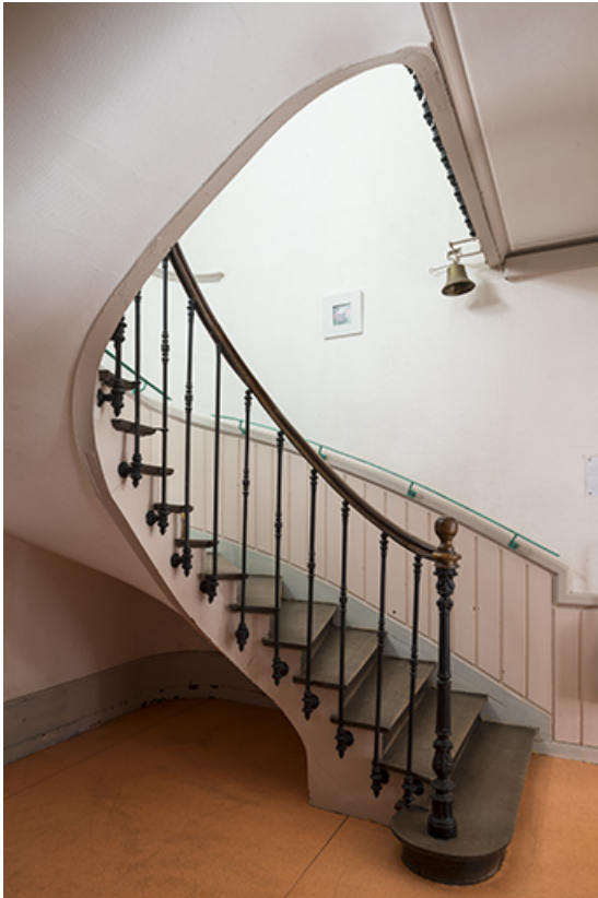
Escalier de type suspendu.
