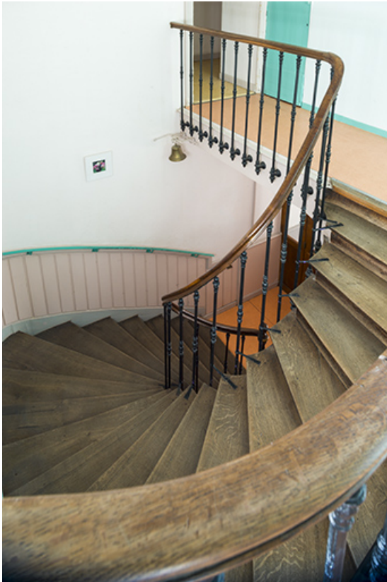
Détail depuis le premier étage.
