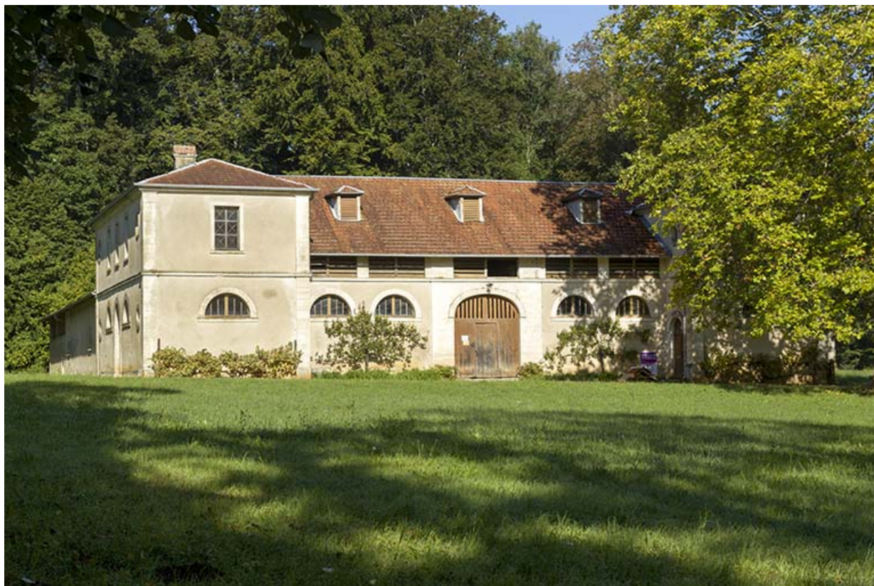
Vue générale de la façade sud-est.
