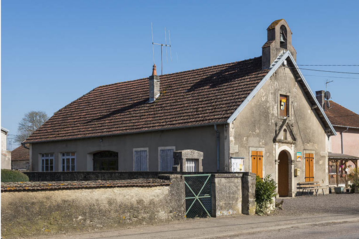
Vue latérale de l'édifice.
