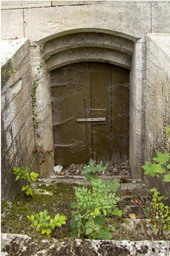
Détail : porte conduisant au sous-sol.
