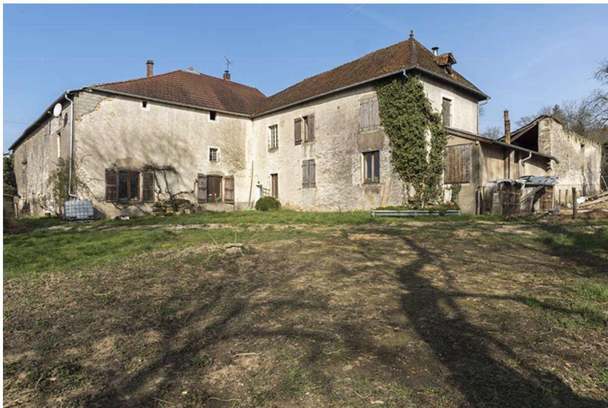
Vue générale, façade postérieure.
