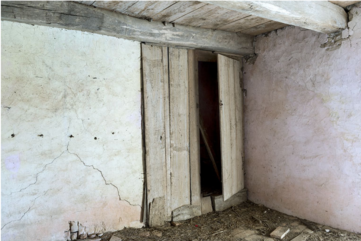
Porte pour accéder à l'étage du pigeonnier.
