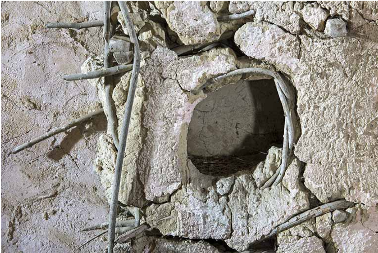
Détail d'un boulin.
