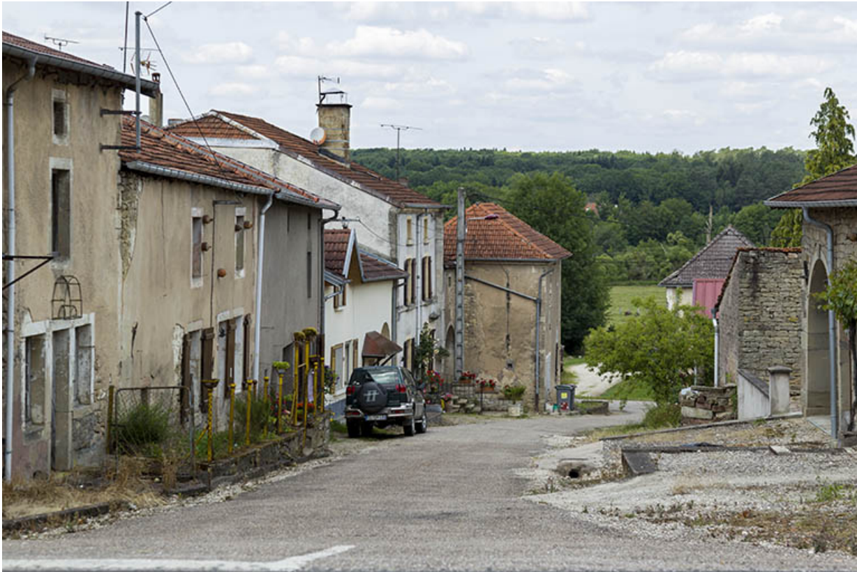
Alignement rue de la fontaine.
