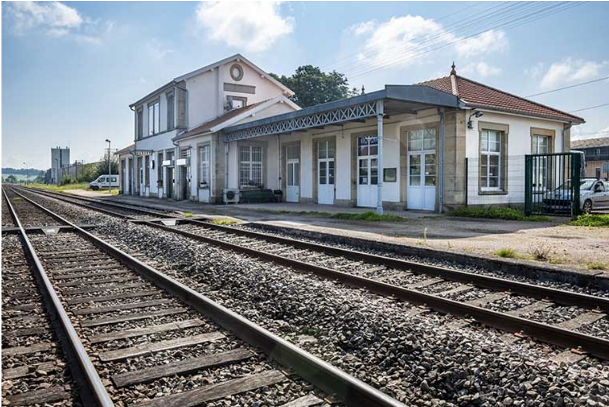
La gare, vue éloignée depuis les voies.
