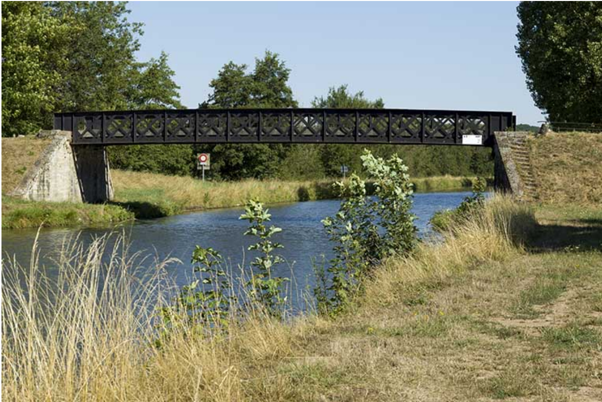
Le pont depuis l'aval.
