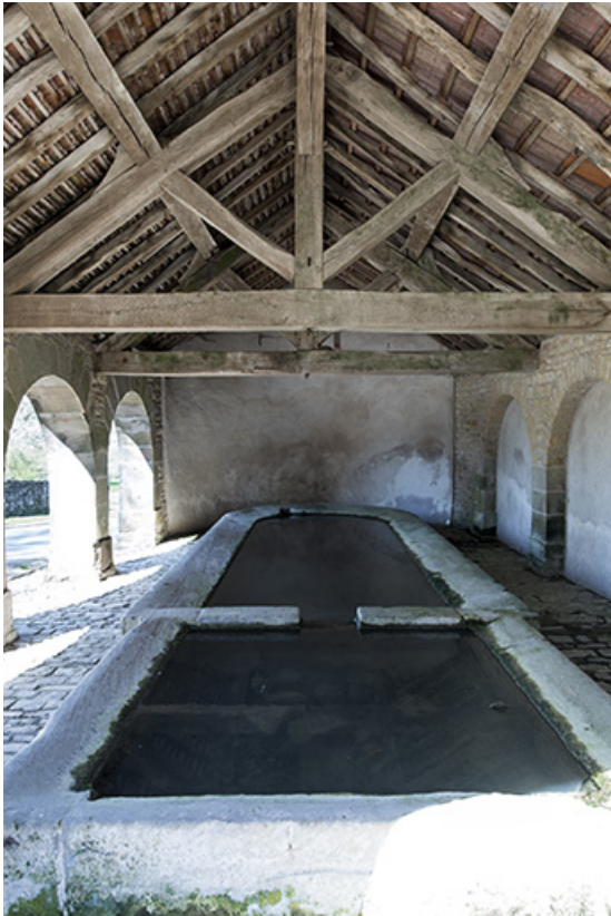
Bassins du lavoir.
