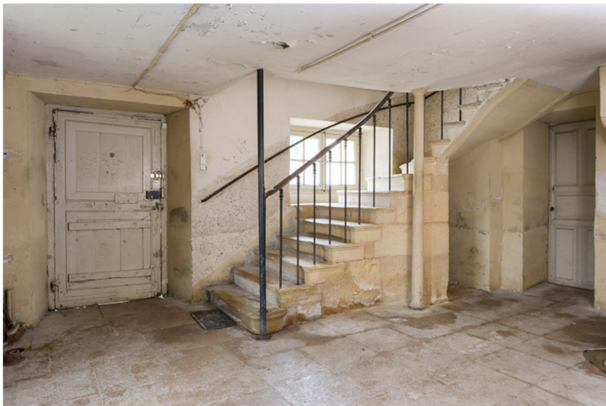
Escalier d'accès au rez-de-chaussée depuis le sous-sol.
