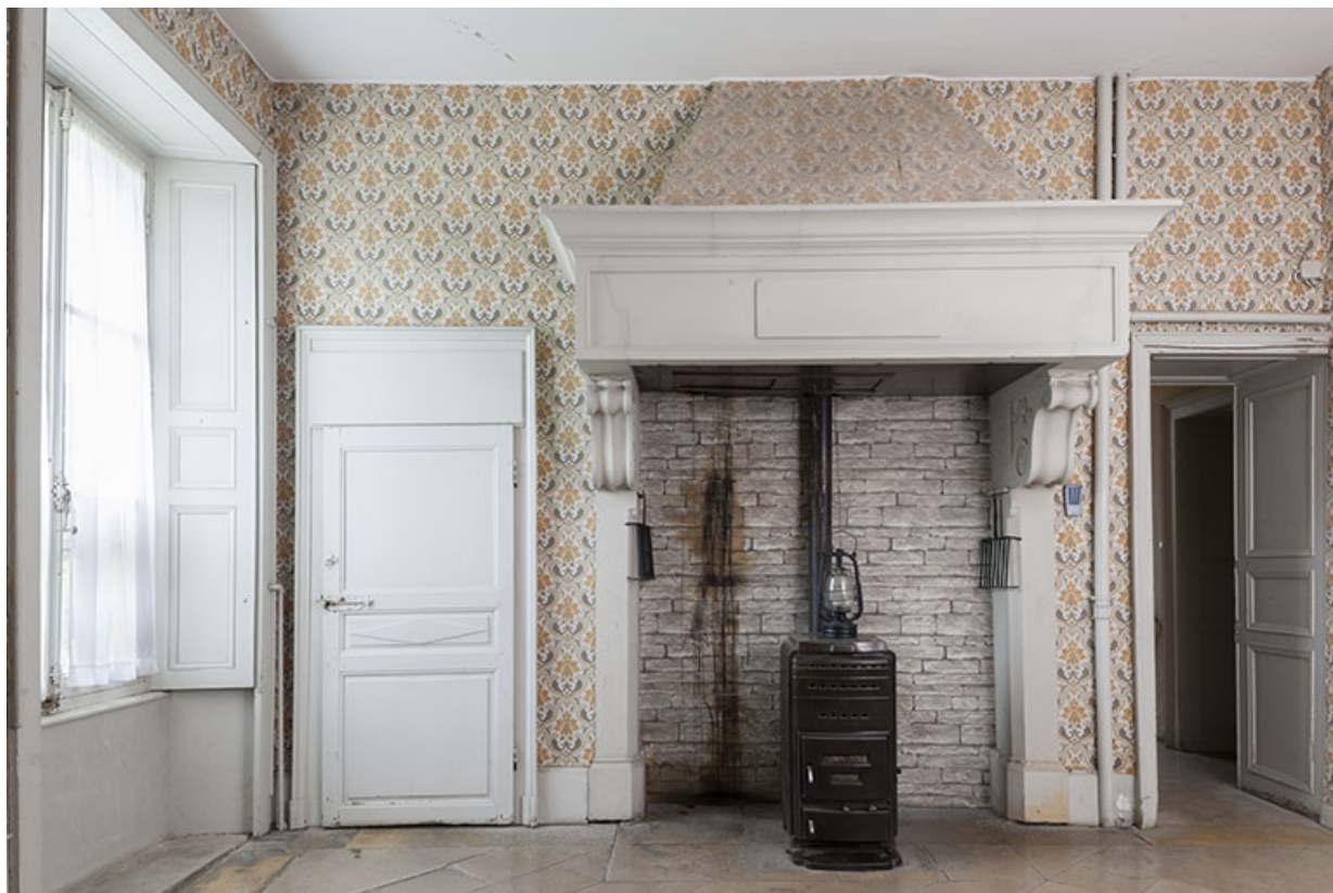
Cheminée de l'ancienne cuisine du rez-de-chaussée.
