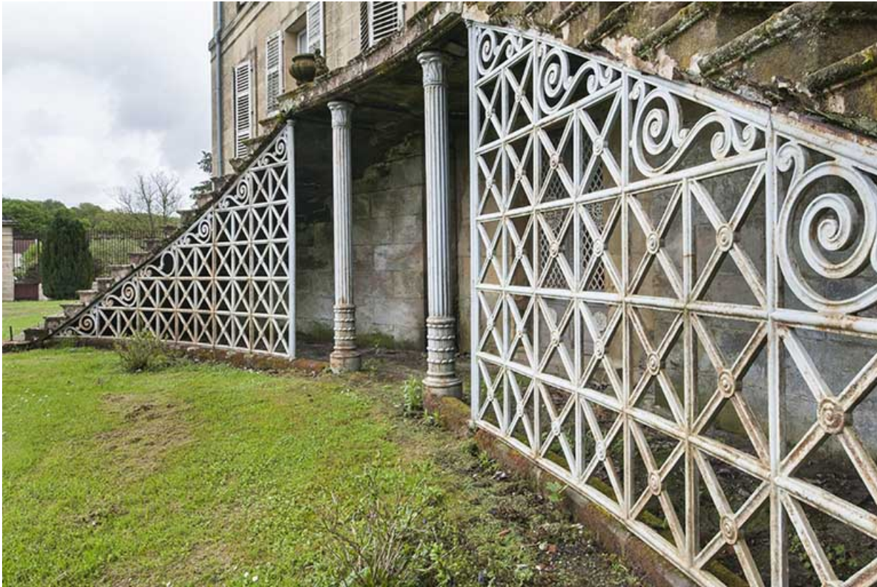
Structure métallique soutenant l'escalier.
