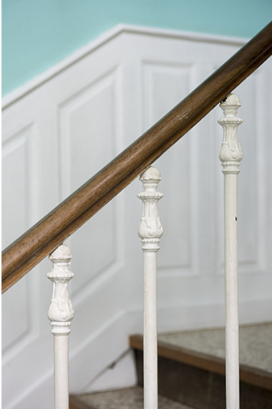
Détail de la rambarde et du garde-corps.
