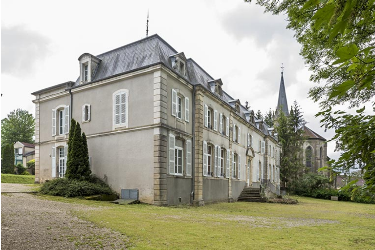
Vue depuis le nord.
