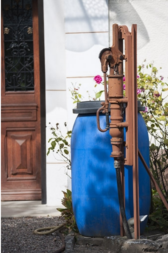
Pompe à eau manuelle.
