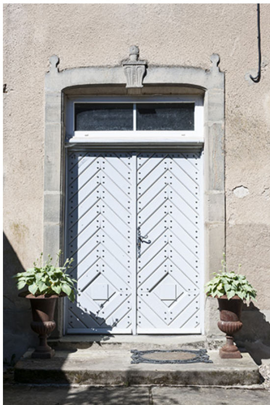
La porte d'entrée, façade est.
