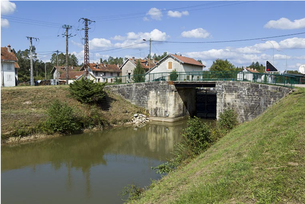
Depuis l'aval, vue sur le pont routier.
