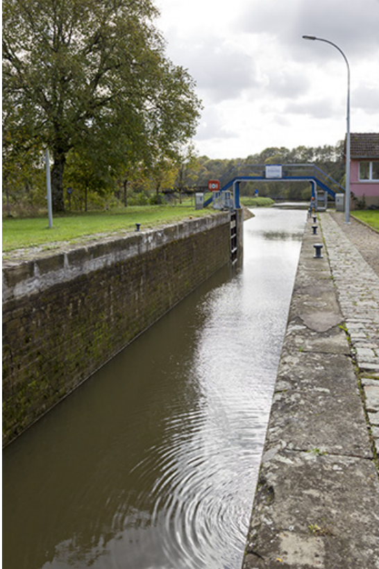
Vue de l'écluse vers l'aval.
