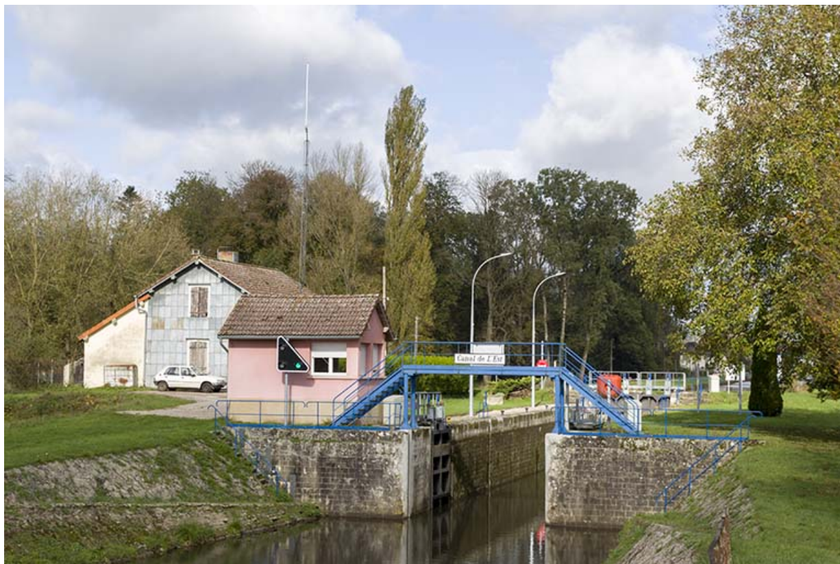
Vue du site d'écluse depuis l'aval.
