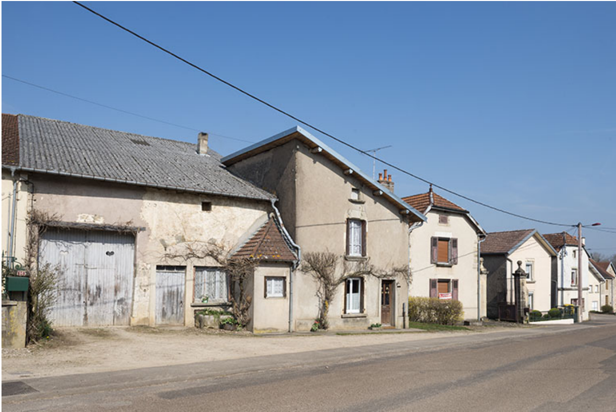
Vue générale, Grande rue.
