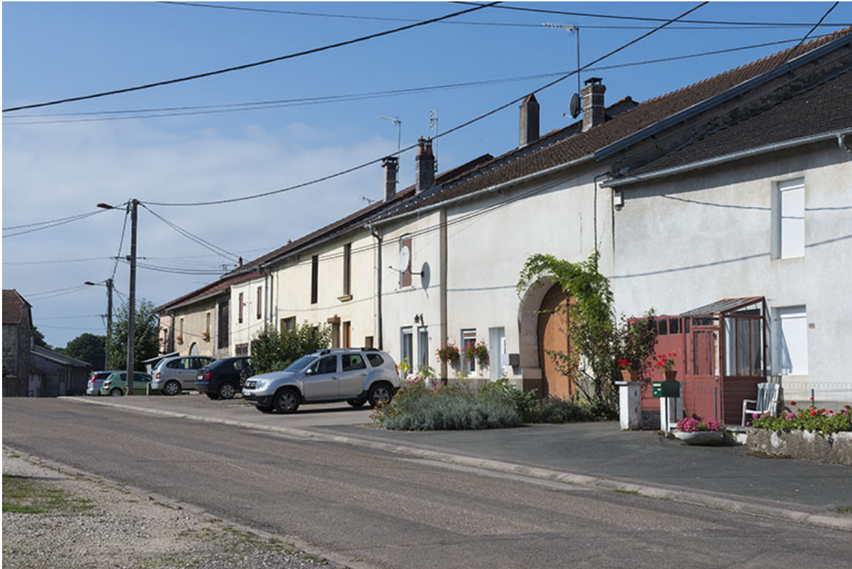
Vue générale, Grande rue.
