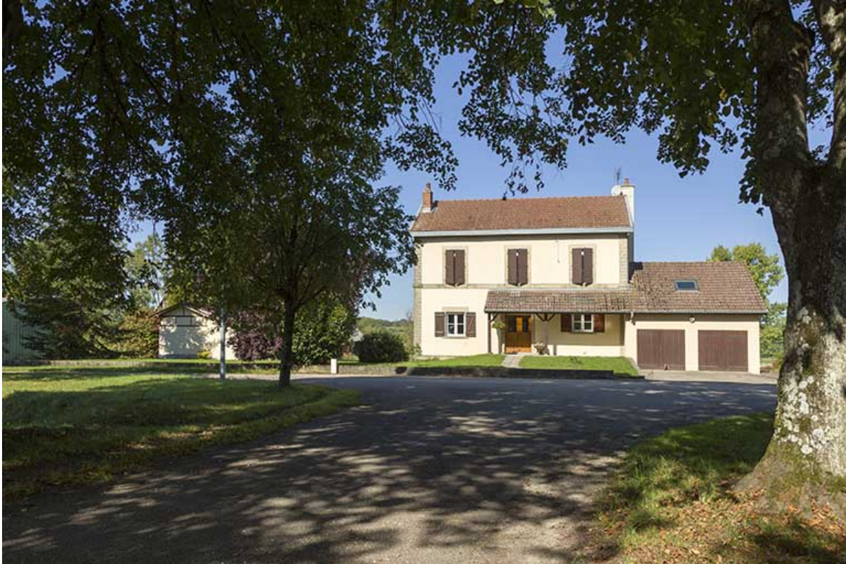
Façade sud-est de l'ancienne gare.
