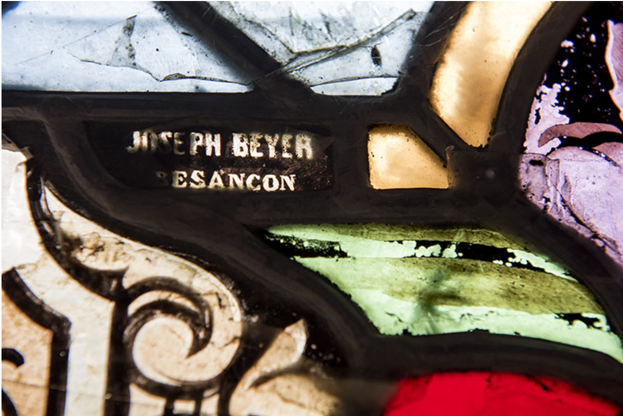
Détail de la verrière : signature.
