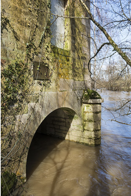
Canal de fuite du moulin.
