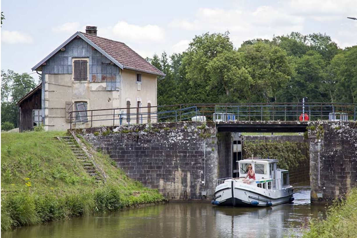
L'écluse, depuis l'aval.
