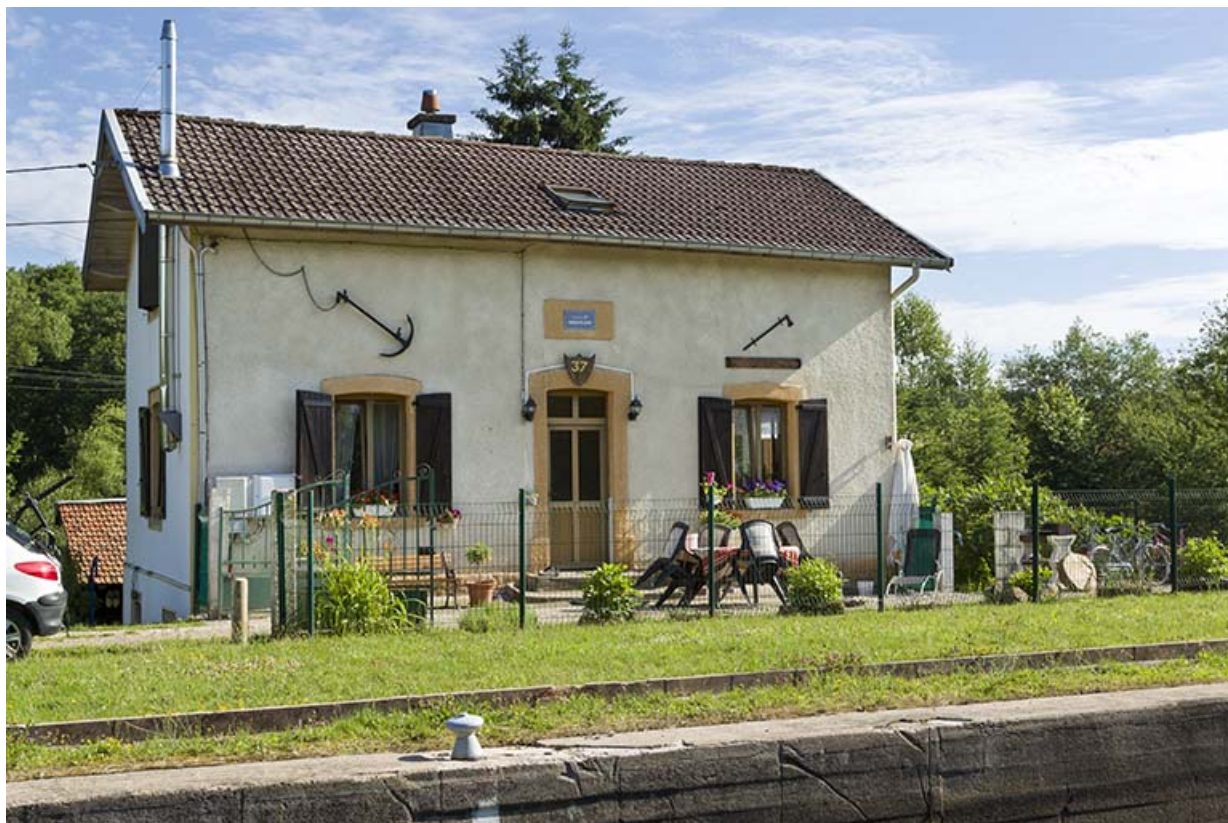
La maison d'éclusier, depuis l'écluse.
