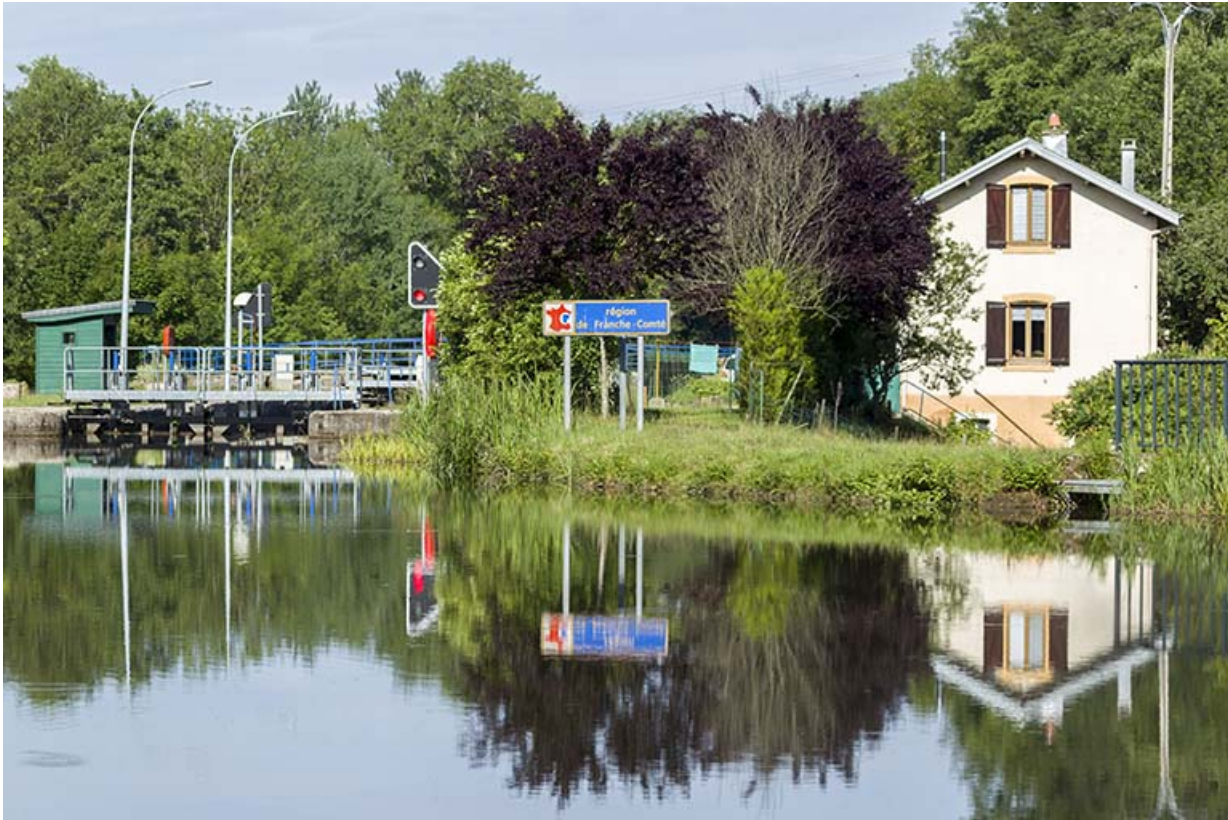
Vue d'ensemble depuis l'amont.
