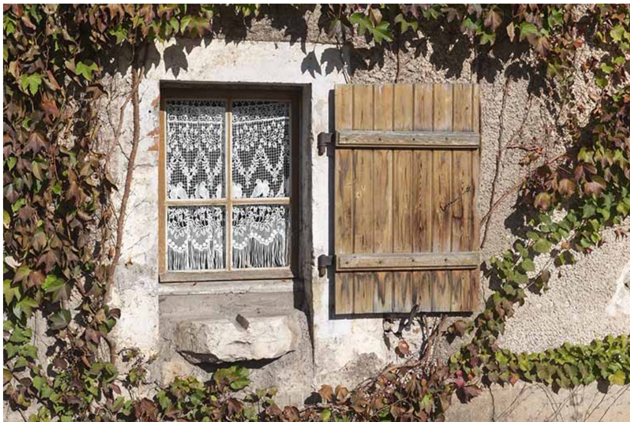
Maison, ancienne auberge et relais de poste, 3 rue des Glacis, détail : la fenêtre de la cuisine avec la sortie d'évier (ou goulotte). 70, Faverney, 3 rue des Glacis
