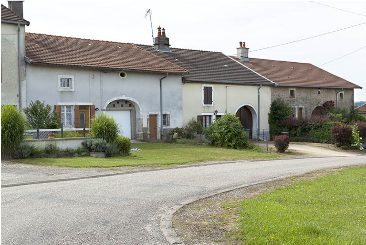
Alignement de fermes, rue de Pont-du-Bois. 70, Selles
