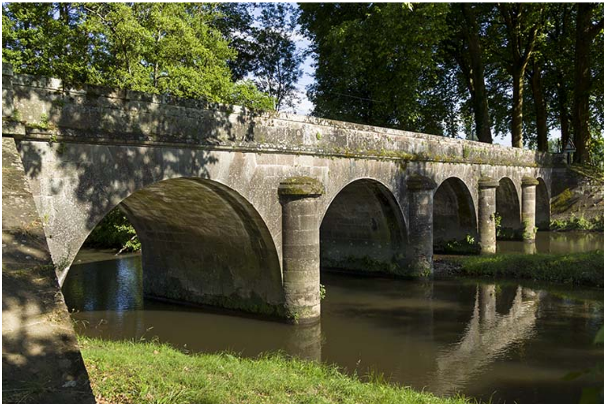
Vue du pont en aval.
