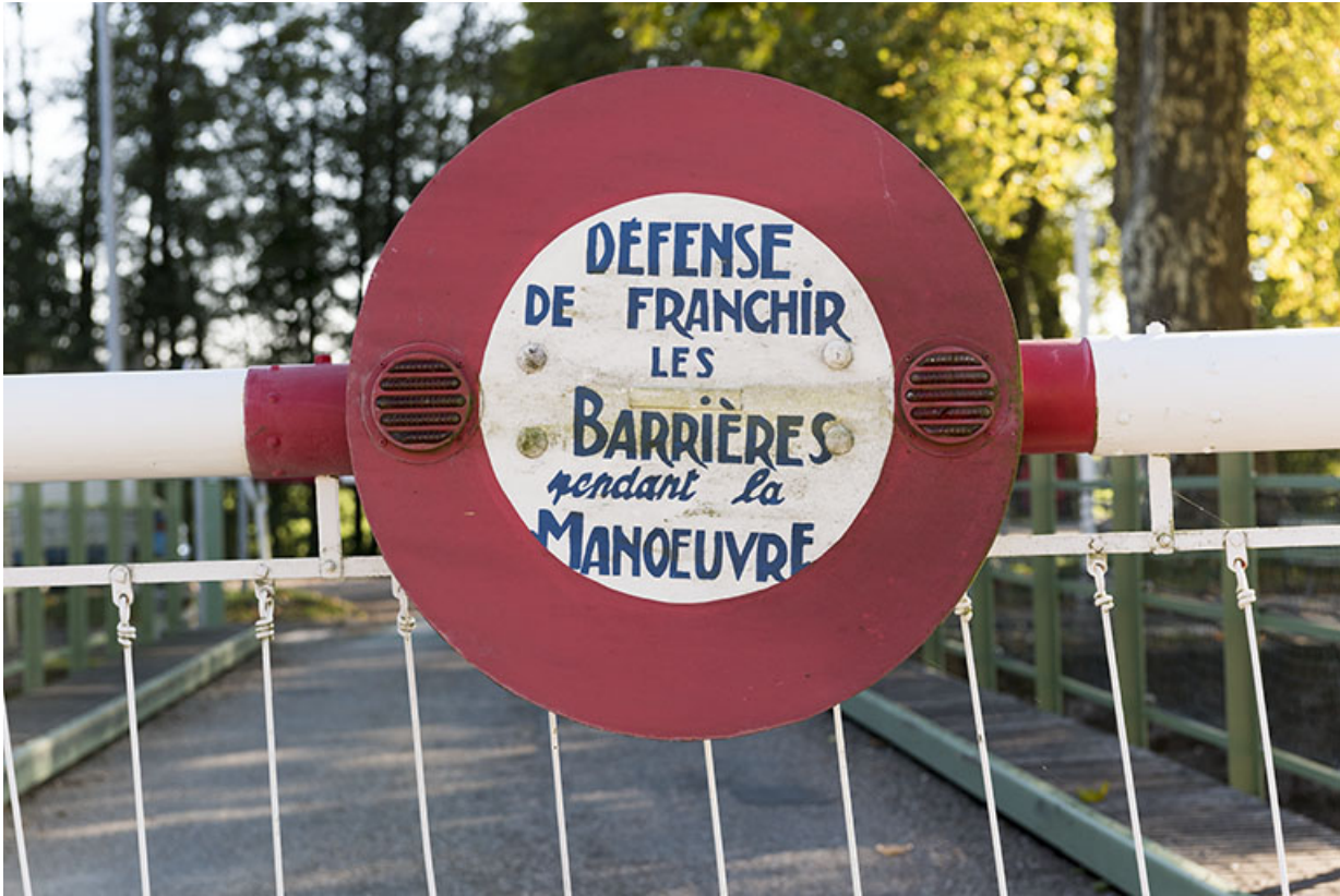
Panneau de signalisation de la barrière.
