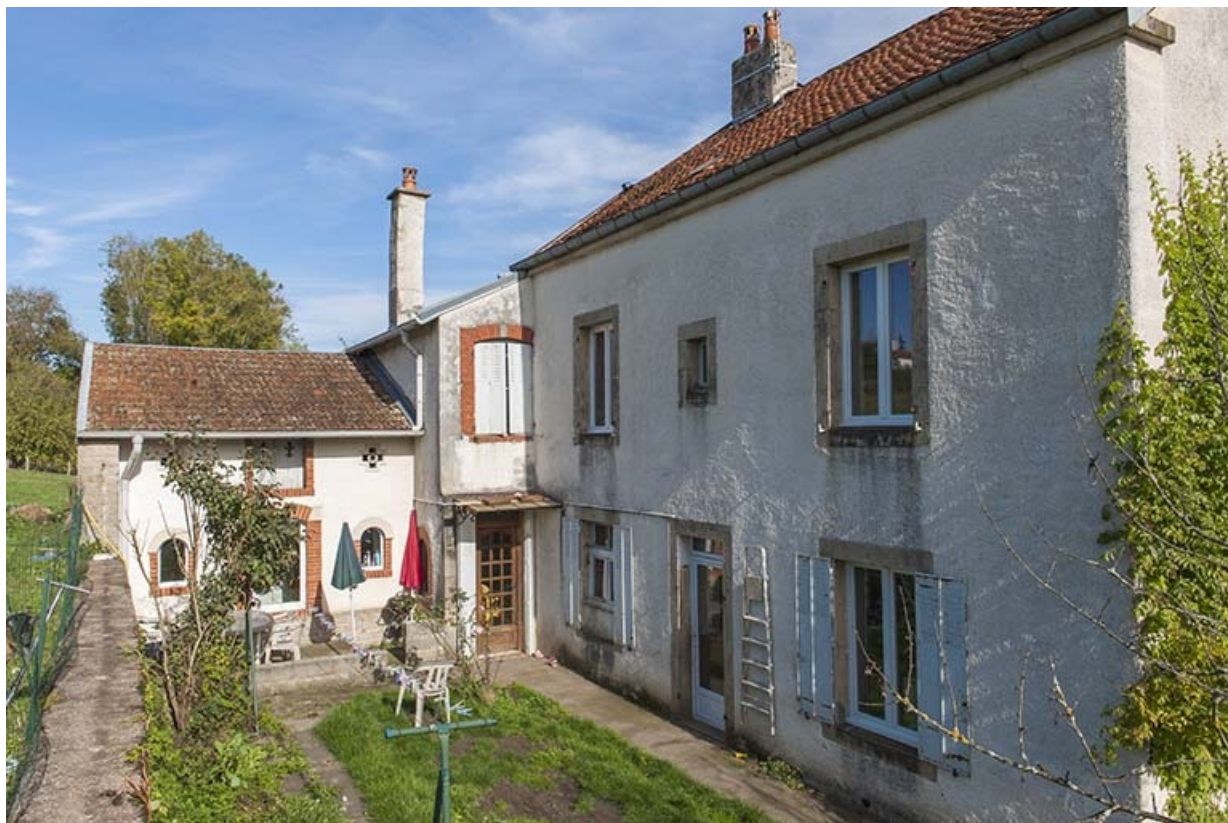
Façade postérieure et remise.
