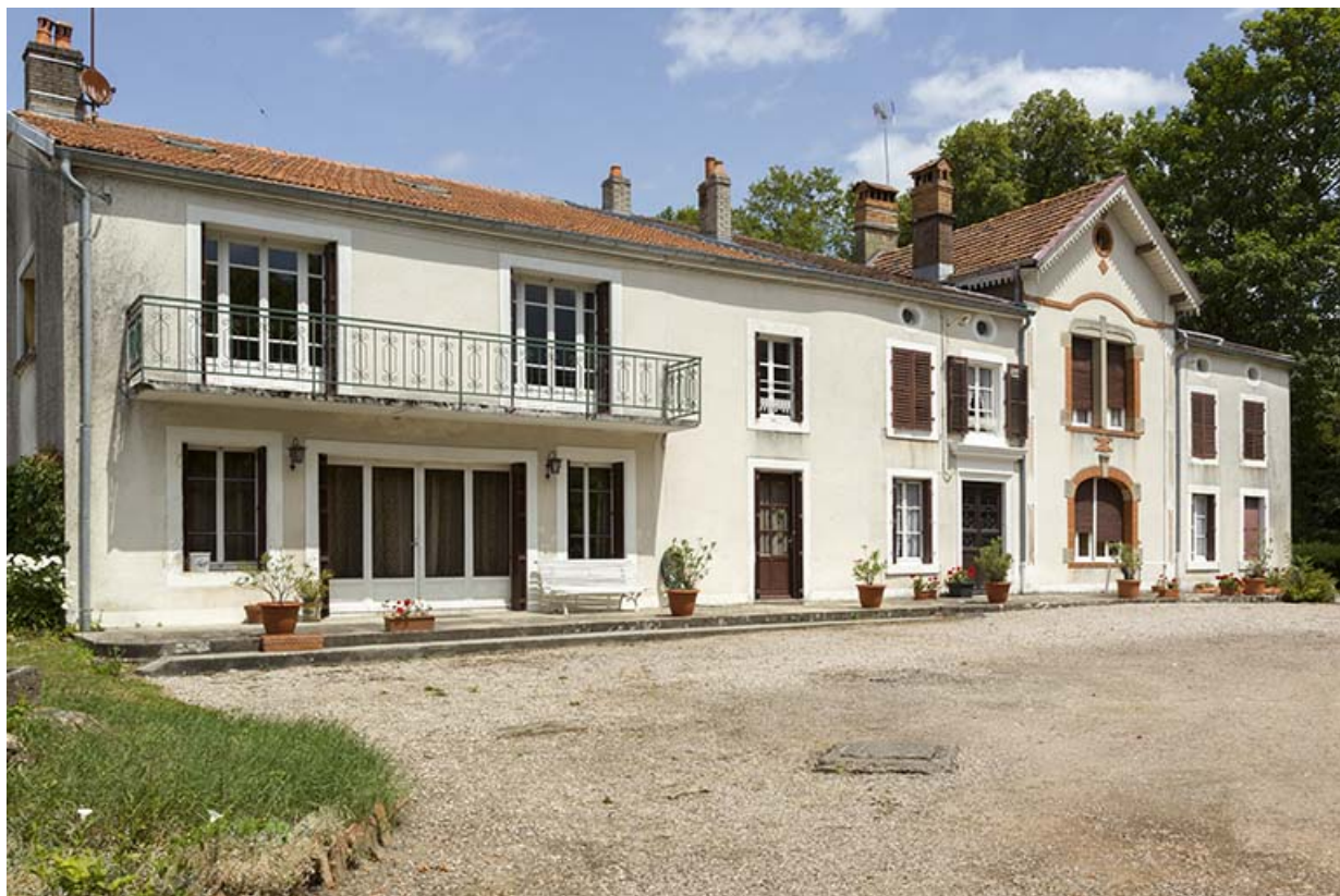
Maison "Boileau", ancien directeur de la verrerie.
