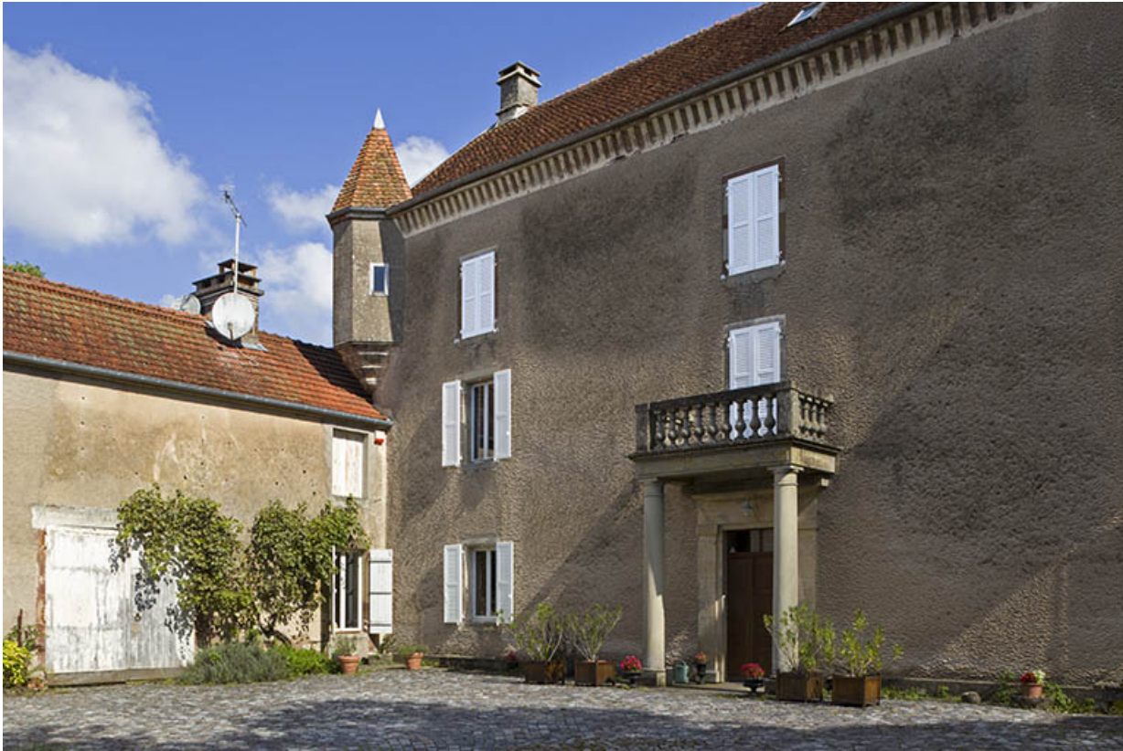
La cour, façade postérieure.
