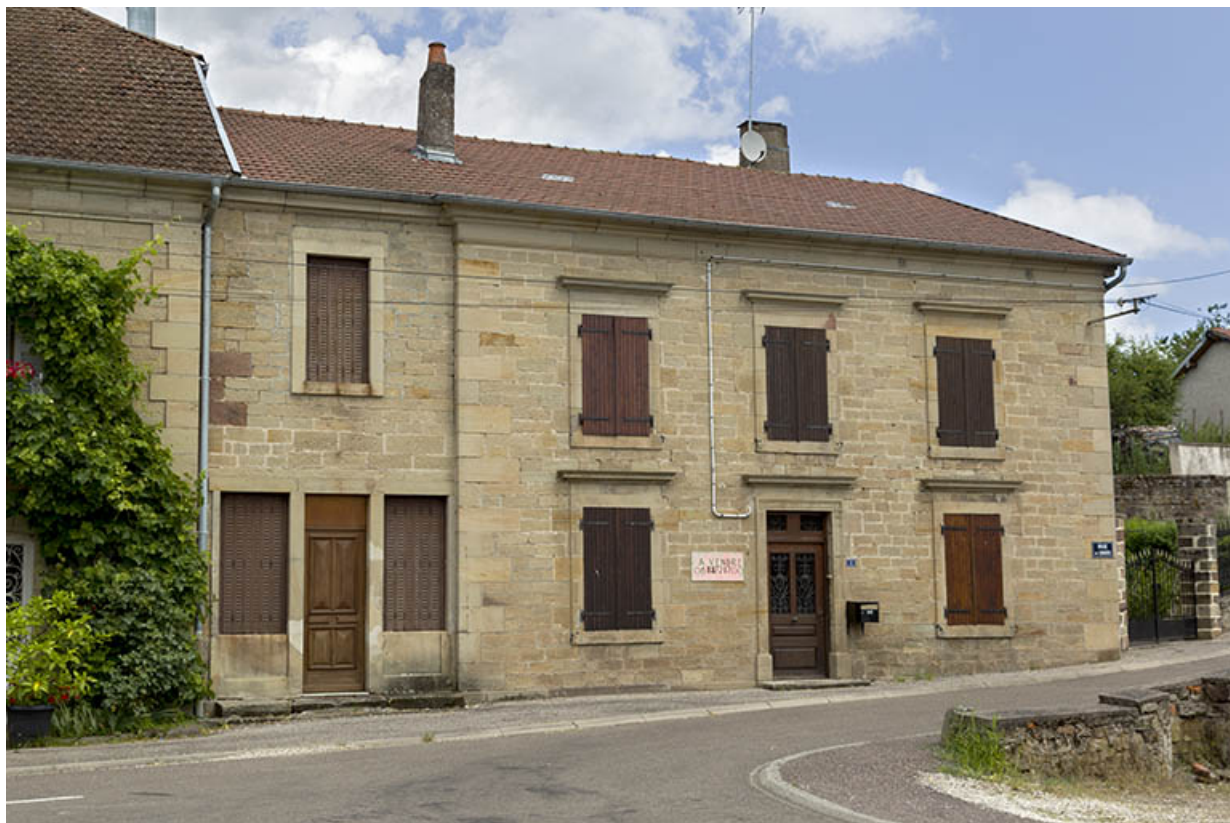
Maison, rue Couelle.
