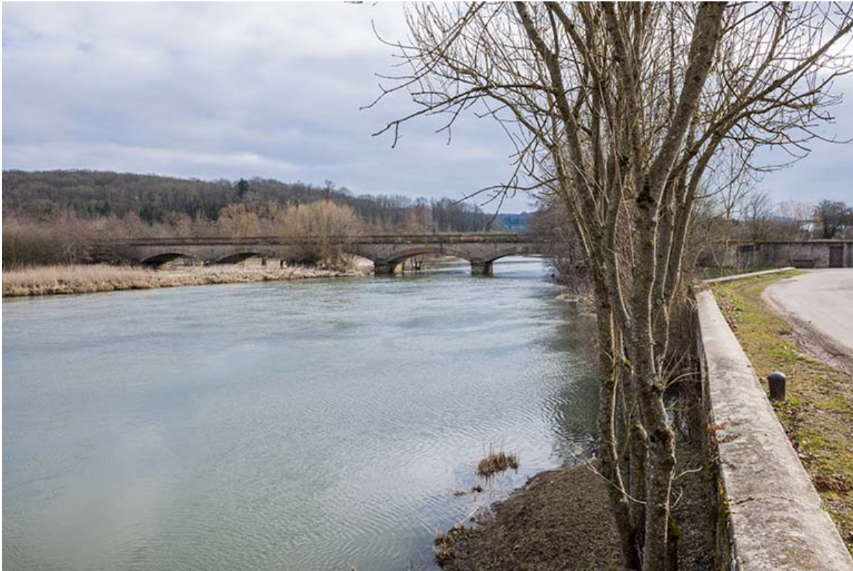
Pont ferroviaire sur la Lanterne (ligne Nancy-Gray).
