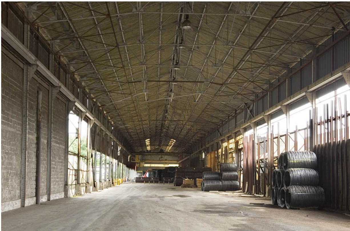
Vue intérieure d'un entrepôt industriel.
