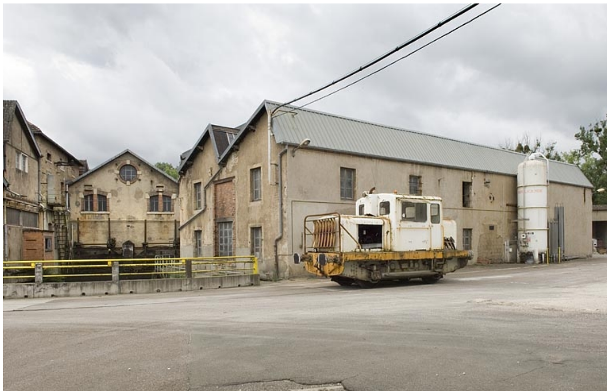
Bâtiment d'eau et atelier couvert de sheds.
