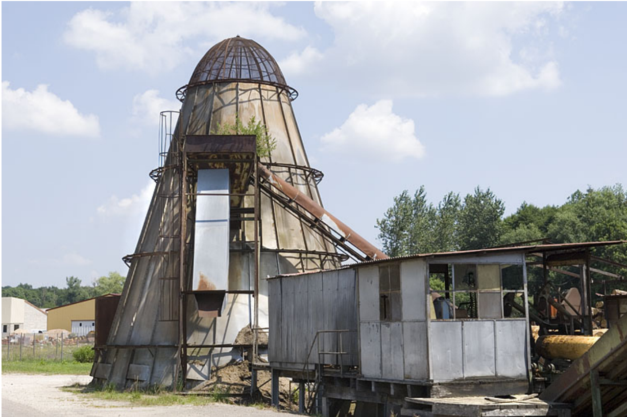
Poste d'écorçage et four à écorces.
