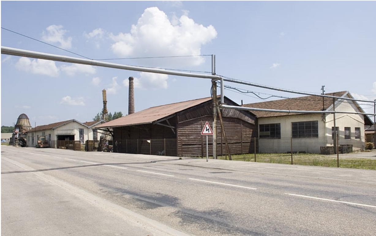
Vue d'ensemble depuis la rue Emile Hauviller.
