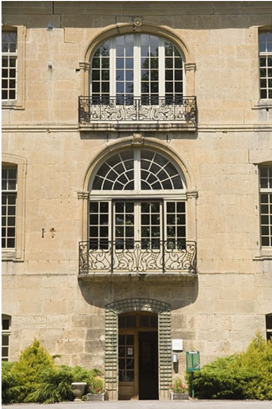
Façade sud du logis abbatial. Travée centrale.
