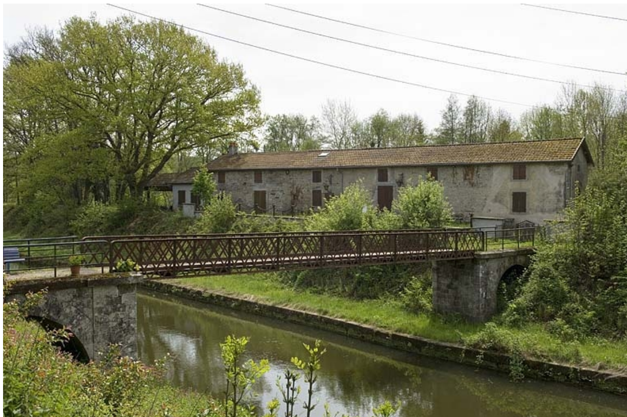
Vue d'ensemble du logement ouvrier collectif (est).
