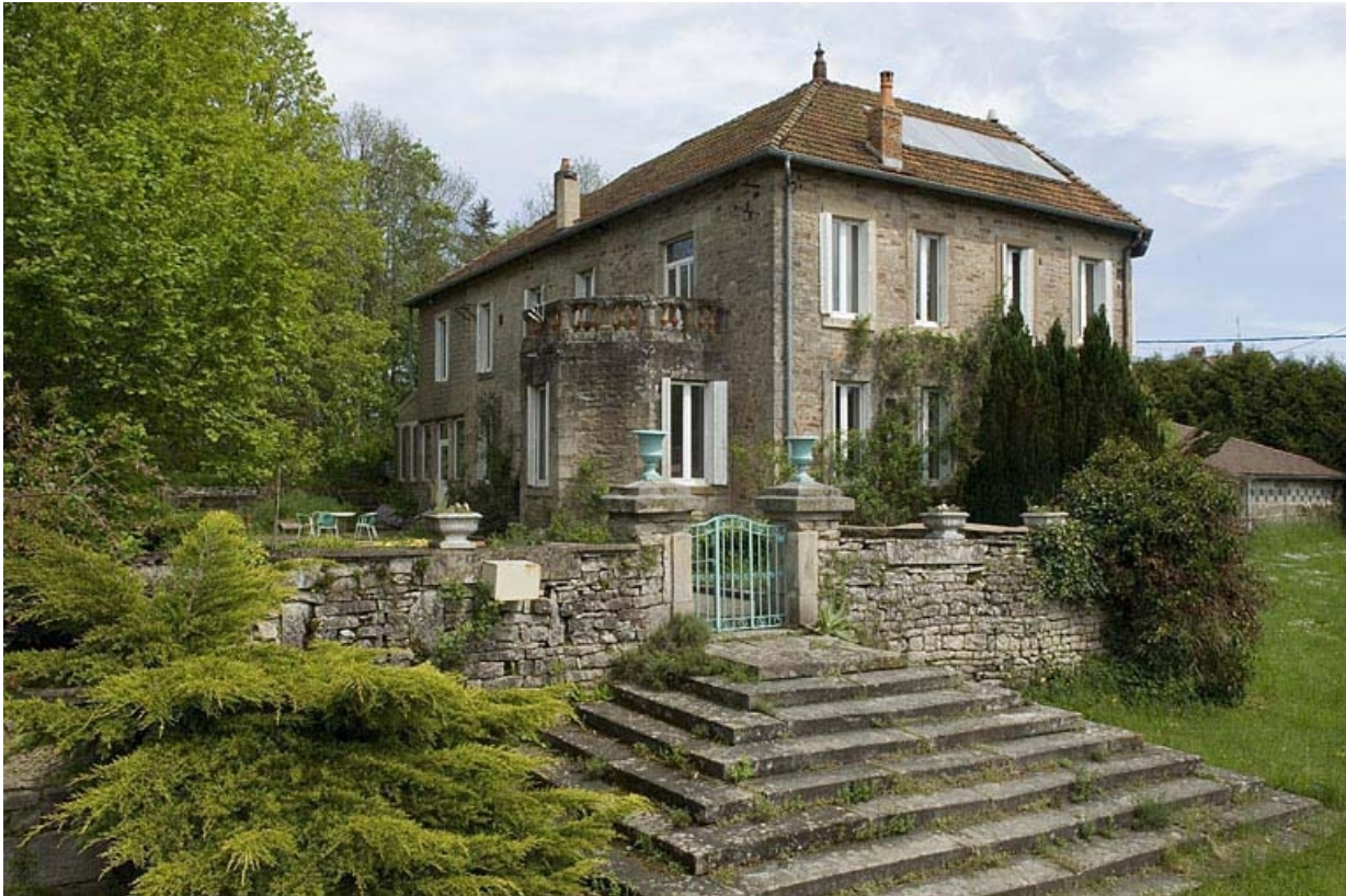
Logement patronal vu de trois quarts.
