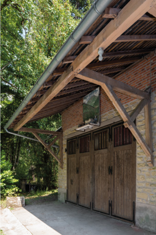
Entrée en façade nord-ouest.
